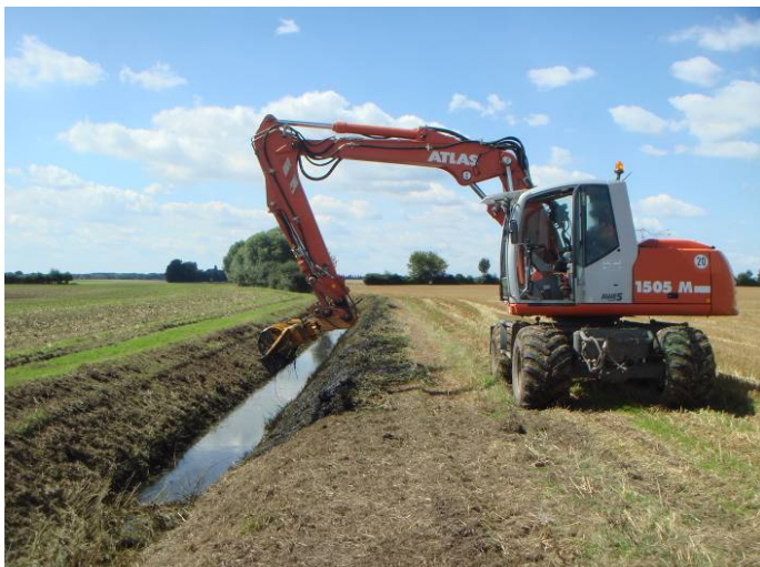
Abbildung 1: Gewässerunterhaltung mit dem Mähkorb bei Köthen, LK Anhalt-Bitterfeld
