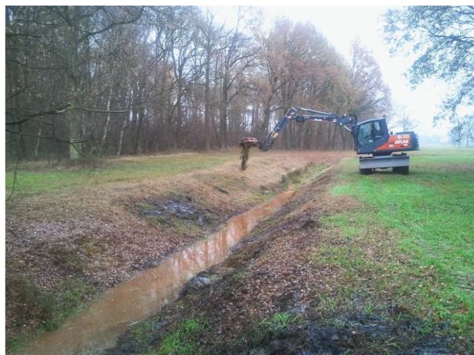
Abbildung 2: Gewässerunterhaltung mit dem Mähkorb, Binnengraben bei Altensalzwedel
