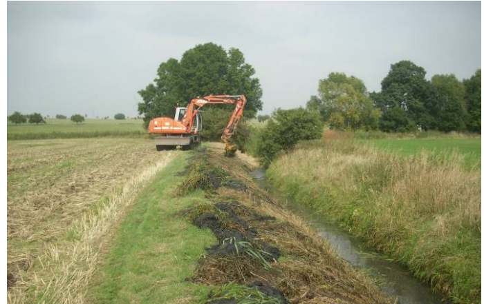
Abbildung 17: Mahd von Röhrichtbeständen mit dem Mähkorb, Zufluss zur Fuhne bei Wettin -Löbejün, OT Plötz
