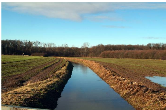
Abbildung 3: Polderentwässerung mit temporärer Wasserführung und regelmäßiger intensiver Gewässerunterhaltung, Elbenauer Landgraben bei Ranies
