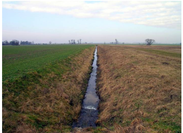
Abbildung 7: Ausgebauter Entwässerungsgraben mit regelmäßiger intensiver Unterhaltung, Ehleseitengraben bei Dannigkow
