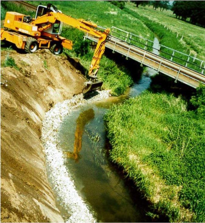
Abbildung 6: Instandsetzung erodierter Böschung, obere Ehle bei Zeppernick
