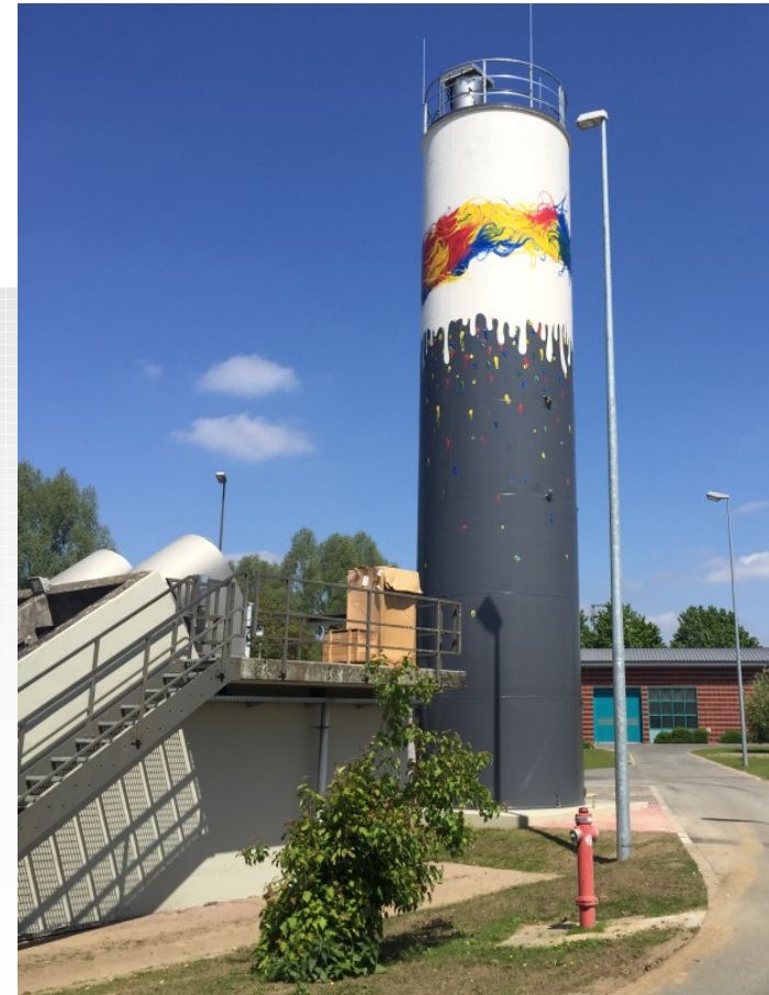
Kläranlage Dülmen (Adsorption mit Pulveraktivkohle)
