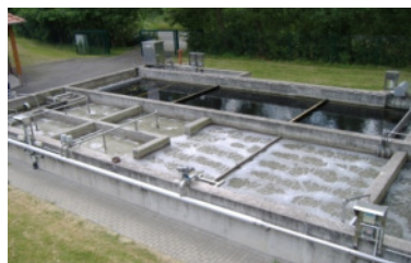
Kläranlage B mit aerober Schlammbehandlung
