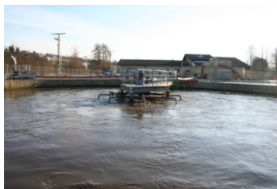
Kläranlage D mit aerober Schlammbehandlung
