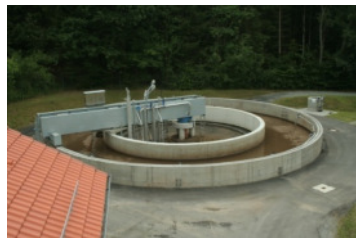
Kläranlage A mit aerober Schlammbehandlung
