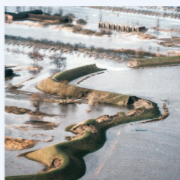
Bruch des Elbdeiches in Kehdingen während der Januarflut 1976
