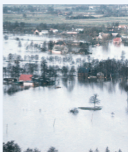
Verheerende Überflutung von Siedlungen und Nutzflächen als Folge des Deichbruchs
