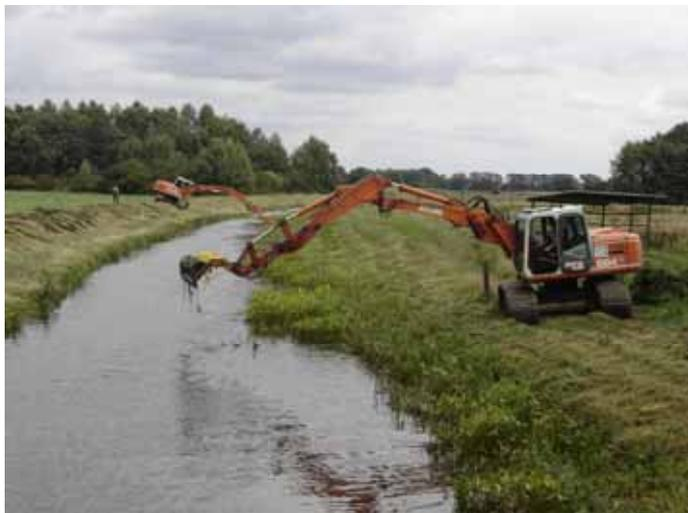
Abbildung 1: Ausgebautes Gewässer mit intensiver maschineller Gewässerunterhaltung, Schwarzwasser bei Oppershausen
