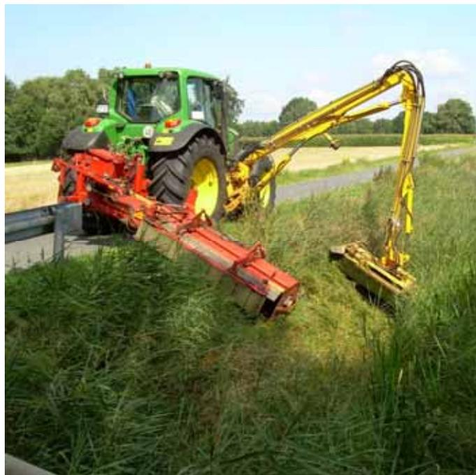
Abbildung 5: Unterhaltung eines Entwässerungsgrabens mit dem Schlegelmäher, Barnbruchgraben bei Gifhorn
