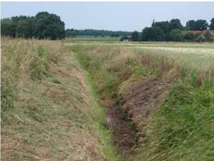
Abbildung 6: Ausgebauter Entwässerungsgraben mit regelmäßiger intensiver Unterhaltung und Böschungsinstandsetzung, Wellendorfer Graben bei Kl. Pretzier
