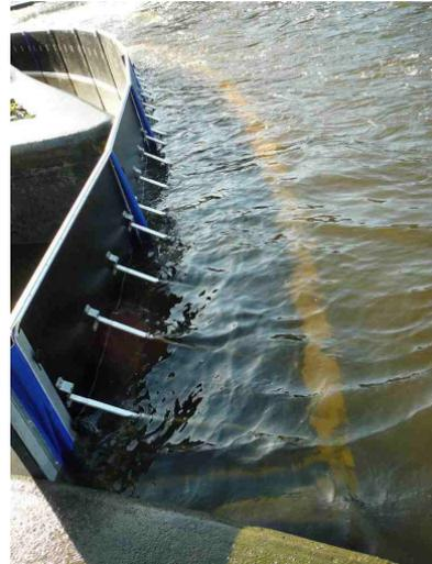
Zwischen Wandverschuß und Wand wird mit einer Gummidichtung abgedichtet. Die andere Seite des Wandverschlusses bietet entweder die Protan-Folienseite oder die Klemmseite – je nach Abschlusseite des Elementes. Diese wird dann durch Klemmleisten, Falz der Protanfolie und einer zusätzlichen Bodenklemme dicht miteinander verbunden. Es ist dasselbe Prinzip mit dem die AquaFence Elemente miteinander verbunden werden.
