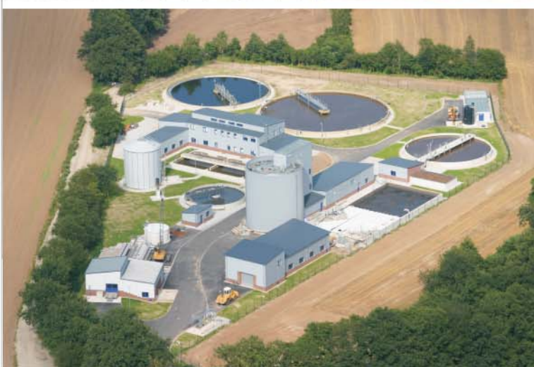
Foto: WV Bersenbrück; Kläranlage Quakenbrück
