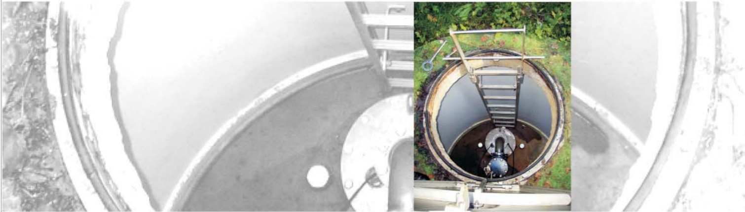
Foto: WVV Land Hadeln; Brunnenschacht
