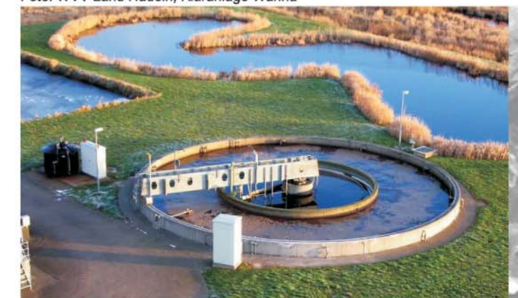
Foto: WV Land Hadeln; Kläranlage Wanna
