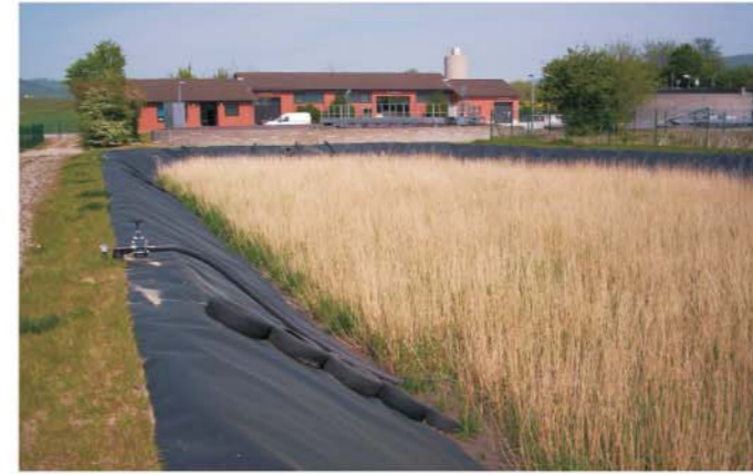
Foto: WVIW; Klärschlammvererdung
