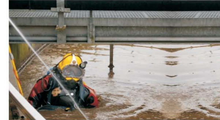
Foto: WAV Osterholz; Einbau eines Rührwerks
