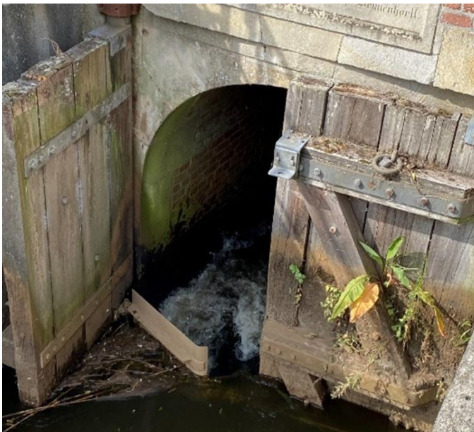
Abbildung 25: Eines von zwei Sieltoren arretiert zur „Frischwasserzuführung“ bei Tidehochwasser.
