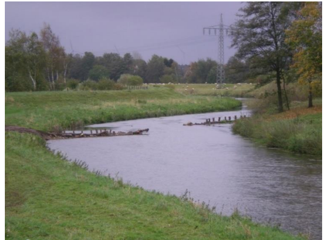
Abbildung 17: Totholz-/Kieseinbau zur eigendynamischen Entwicklung bei hydraulischen Reserven mit Anpassung der abflusssichernden Maßnahmen, Hase bei Bramsche, Landkreis Osnabrück (2017).
