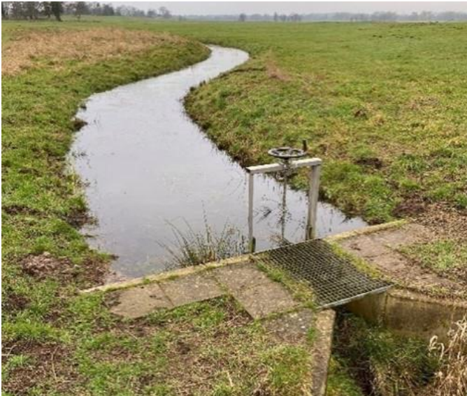
Abbildung 26: Grabenstauanlage im Bereich des Hochwasserrückhaltebeckens Delmenhorst/A 28 mit dem Ziel, die „Durchstechbarkeit“ für Wiesenvögel zu verbessern.
