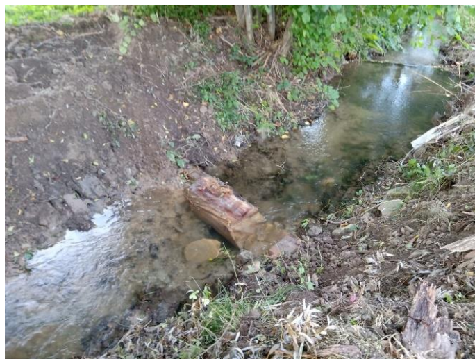
Abbildung 23: Sohlgurt aus Baumstamm mit Niedrigwasserrinne zur Begrenzung einer unnatürlichen Tiefenerosion in der Despe, Landkreis Hildesheim.
