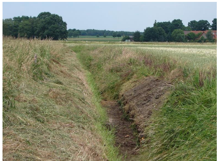
Abbildung 6: Ausgebauter Entwässerungsgraben mit regelmäßiger intensiver Unterhaltung und Böschungsinstandsetzung, Wellendorfer Graben bei Kl. Pretzier, Landkreis Uelzen.
