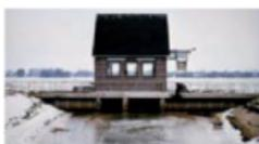
Die Marsch ist mit einem Teller zu vergleichen. Sie ist in der Mitte am niedrigsten und steigt zum Rand (Fluss / Meer) hin an. Das Stufenschöpfwerk hat die Aufgabe, das Wasser von der 2. in die 3. Höhenstufe zu pumpen. Es muss stärker sein als das Dränschöpfwerk, da es größere Wassermengen zu bewältigen hat.
