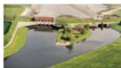
Die Mündungsschöpfwerke stehen im Deich und haben die Aufgabe, bei hohen Fluten und sehr hohen Binnenwasserständen das Wasser aus dem Binnenland abzupumpen, damit Überschwemmungen vermieden werden. Mündungsschöpfwerke sind sehr kostenintensiv (Energie).
